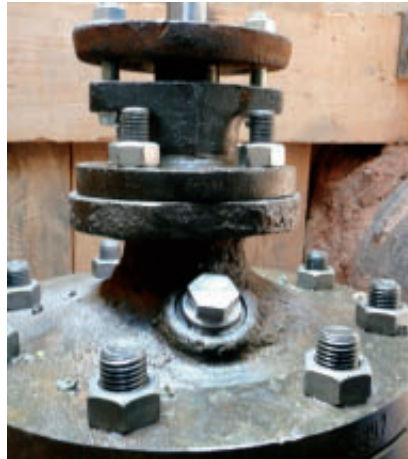
Abb. 8: Vollständig unter Betriebsdruck sanierte erdverbaute Armatur vor der Umhüllung
