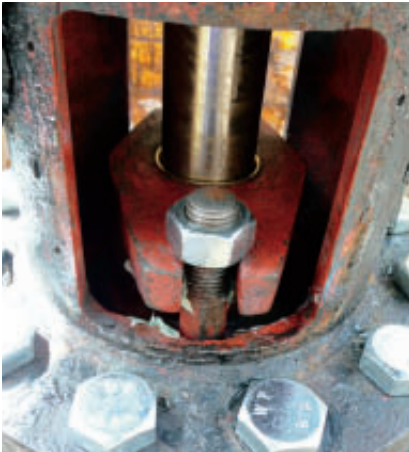
Abb. 7: Blick in den Bereich der Stopfbuchsenbrillen nach erfolgter Umstellung auf O-Ring-Abdichtung
